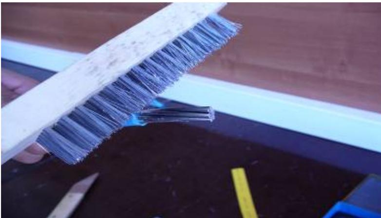
После протирки бензином немедленно смазать зачищенную часть концов жил кварцевазелиновой пастой с помощью специальной лопатки.
